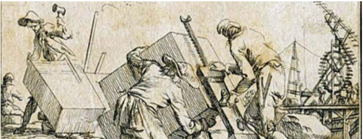
Trabajos de Masonería Operativa
